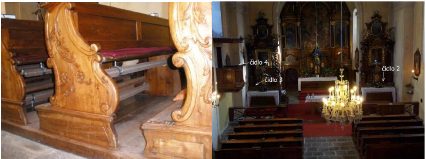
Obr.2 Otopné registry v lavicích, pohled na interiér kostela
